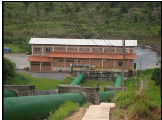
PCHs Agro Trafo
