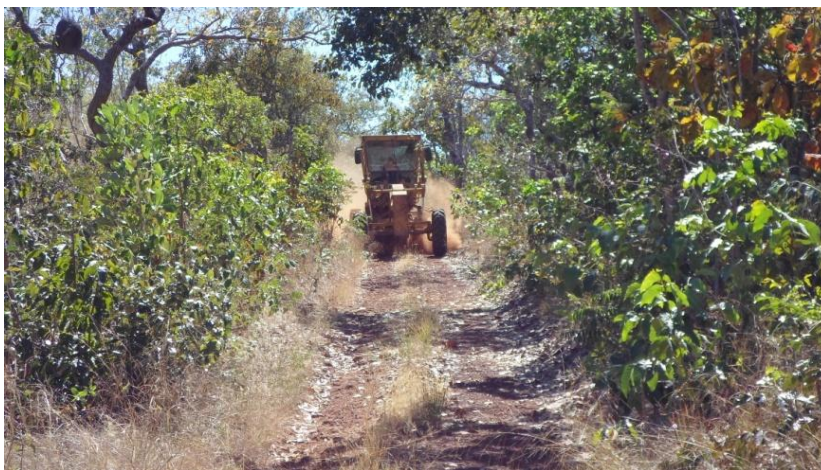
Figura 2. Patrola da SEDER realizando manutenção do aceiro na margem oeste do Parque
