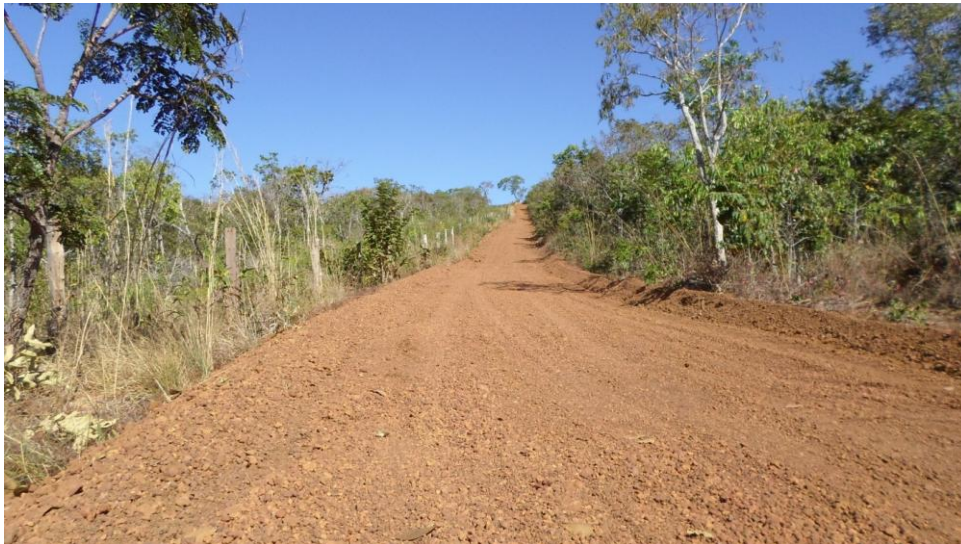
Figura 7. Estrada interna da UC após sua manutenção.
