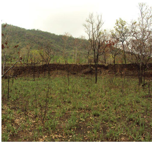
Estrutura em pedra na forma de muro de contenção
