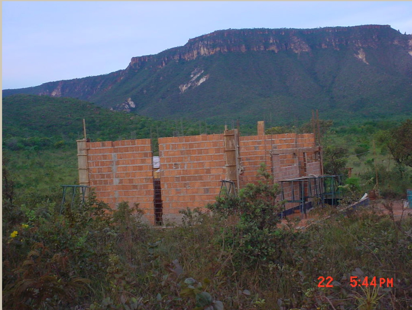
Obras do posto de fiscalização das dunas: iniciadas em janeiro de 2005
