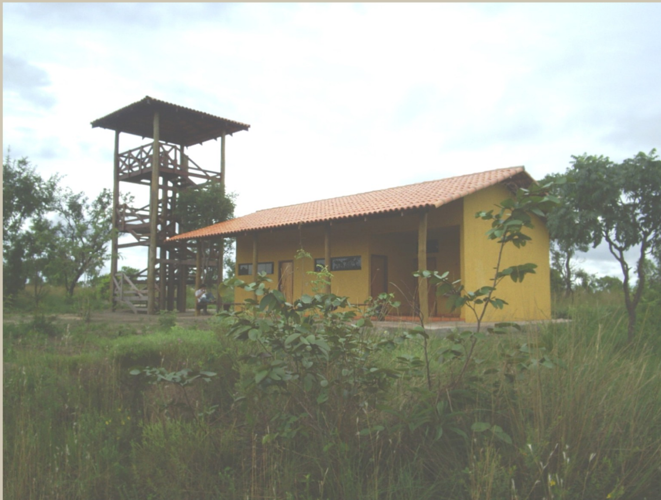
Posto de fiscalização do Rio Novo: Concluído em novembro de 2005
