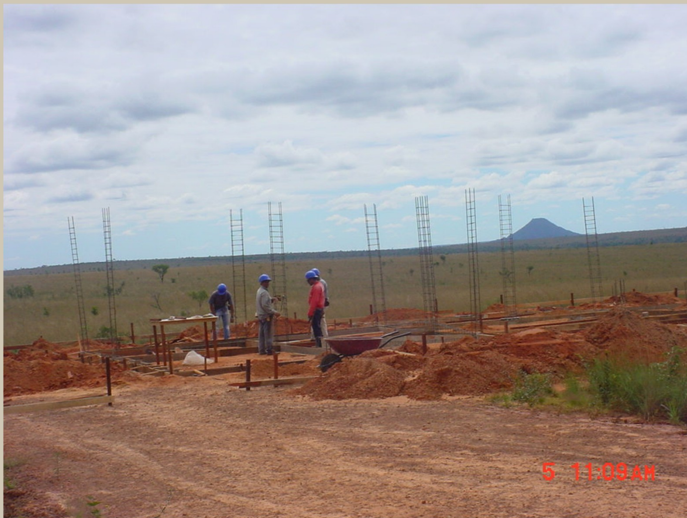
Obras da sede administrativa do PEJ: iniciadas em janeiro de 2005
